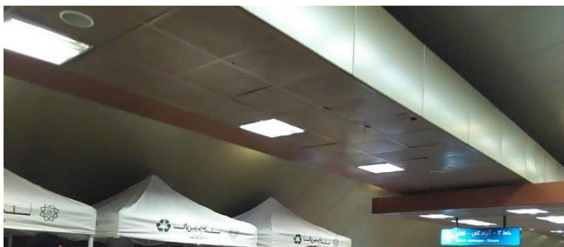
تصویر ۱- سقف کاذب سالن فروش بلیط ایستگاه تئاترشهر
