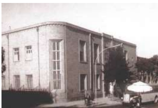
شکل ۴: ساختمان کتابخانه ملی تبریز
