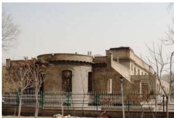
شکل ۷: ساختمان کتابخانه ملی تبریز
