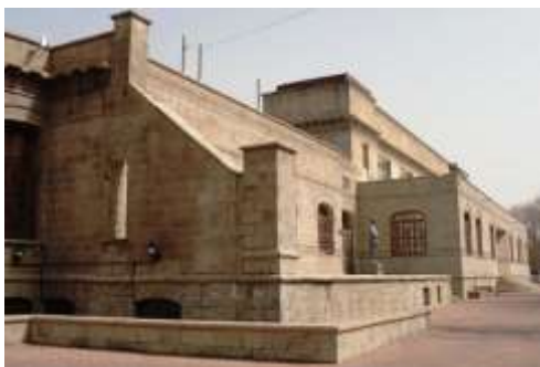
شکل ۵: ساختمان کتابخانه ملی تبریز
