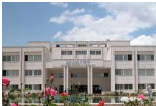
شکل ۶: ساختمان کتابخانه ملی تبریز
