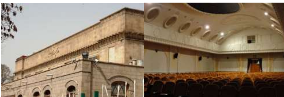
شکل ۸: ساختمان کتابخانه ملی تبریز
