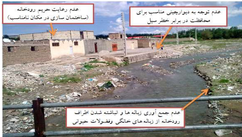
شکل ۳: مشکلات حاشیه رودخانه روستای کندرود که نشان دهنده عدم برنامه ریزی مناسب و توجه نکردن به مسائل محیط زیست است.
