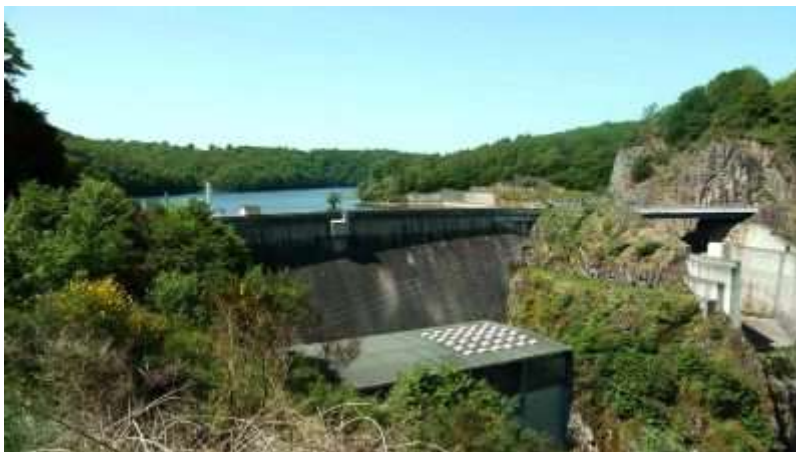
شکل ۲. نمونه ای از سد وزنی (Rochebut) مورد استفاده در نیروگاه برق آبی.
