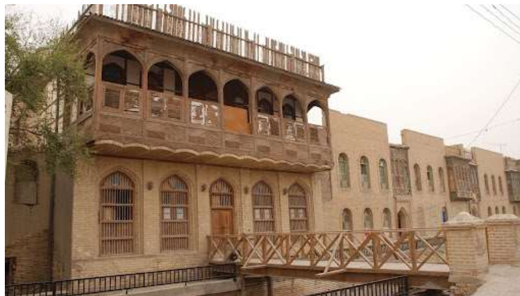
تصویر (۳): نمایی از شناسیل در ساختمان
