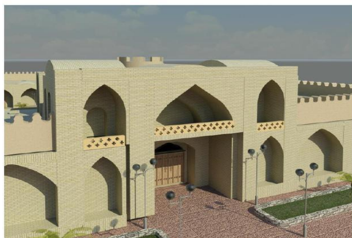
شکل (۱۹): نمای تکمیل شدهی تراس اتاق‌های بالای ورودی و همچنین در ورودی اصلی
