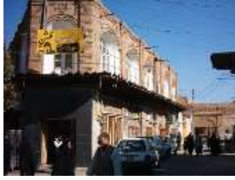
شکل ۱۲- نمای ضلع جنوبی و ضلع جنوب غربی (دید از جنوب غرب) (ماخذ: میراث فرهنگی)
