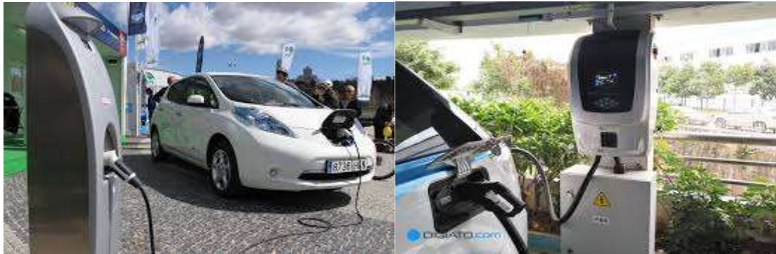
شکل شماره ۴. محل شارژ اتومبیل برقی
